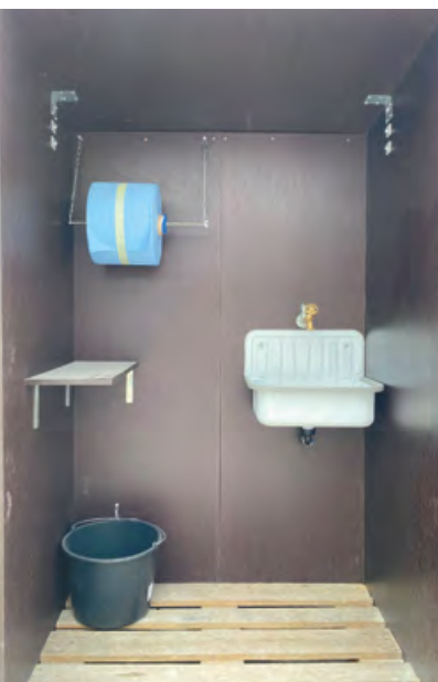
Baustellenbetrieb unter Corona und Hygienestation.
