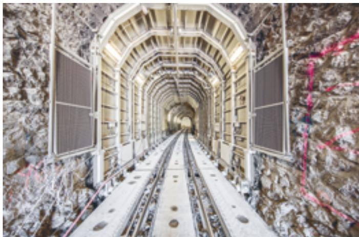
Tunnel Glatscheras sulla linea dell'Albula, metodo di costruzione standardizzato con impalcatura di protezione per lo scavo
