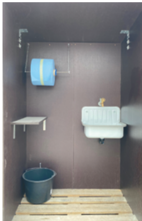
Baustellenbetrieb unter Corona: Hygienestation.
