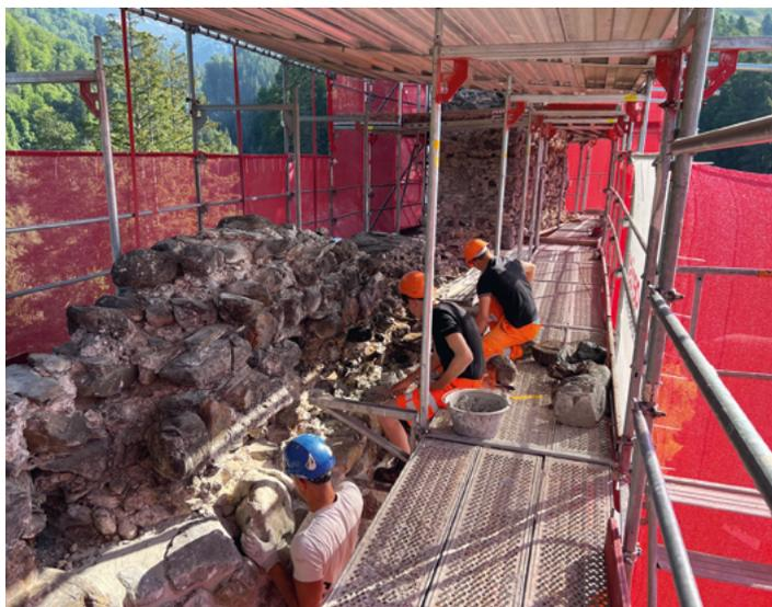
Abbildung: Sicherungsarbeiten an der Mauerkrone
