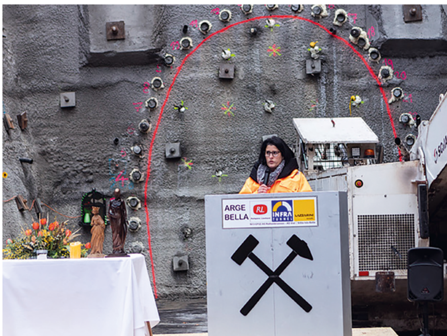
Bild: Ansprache bei der Anschlagfeier des Sicherheitsstollens Tunnel Isla Bella
