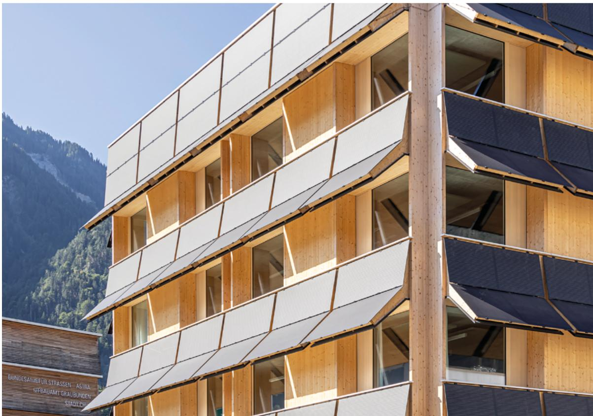
**Bild:** Foto Ingo Rasp – Verkehrsstützpunkt Chur KAPO GR, Fassade mit PV-Modulen
