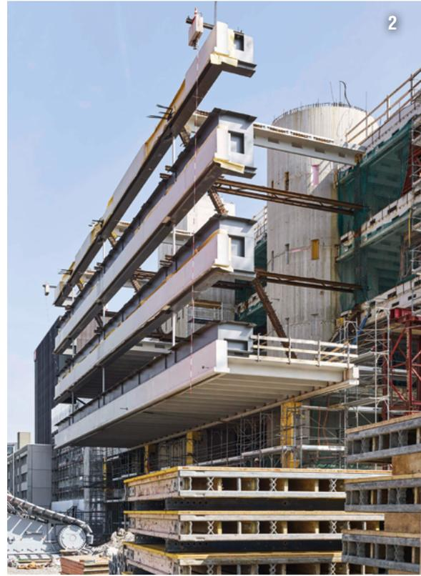
Dank der Schrägstellung der Stützen in Kombination mit Abhängungen konnten die dreiseitigen Auskragungen in einer material-effizienten Bauweise bewältigt werden.
