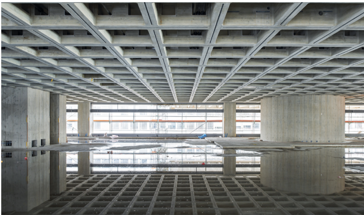
Illustraziun: durant la fasa da construcziun è visibla l'entira portada dal palantschieu sura en furma da giatter.
