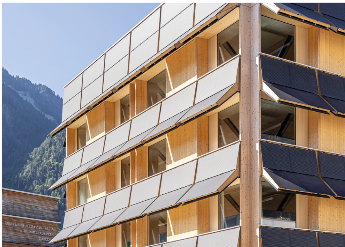
Illustraziun: Foto Ingo Rasp – Verkehrsstützpunkt Chur KAPO GR, Fassade mit PV-Modulen
