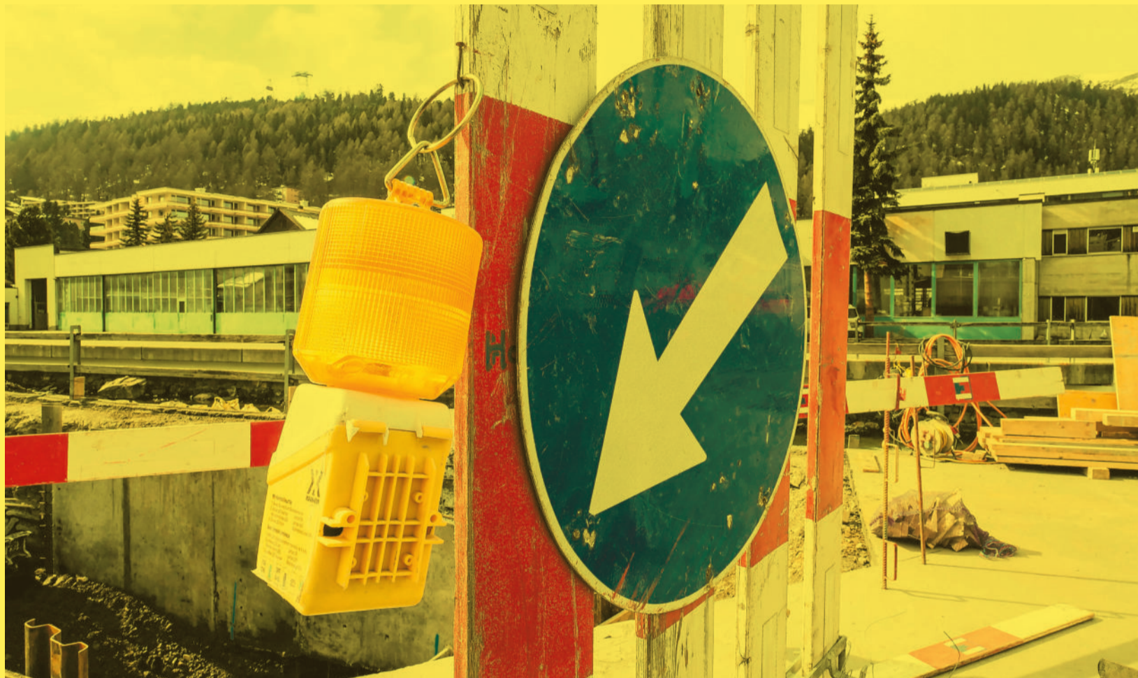
Mit dem traditionellen Start der Bausaison nach den Osterfeiertagen wird es im Zusammenhang mit Baustellen im Hoch- und Tiefbau auch in Südbünden wieder vermehrt zu Einschränkungen oder Wartezeiten kommen. Geduld und gegenseitige Rücksichtnahme sind gefordert. Foto: Jon Duschetta
