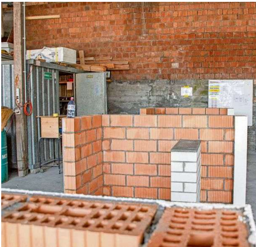
Mauren ist auch Feinarbeit: Der Kursleiter achtet unter anderem darauf, wie schön die Fugen zwischen den Ziegeln gemacht wurden.
