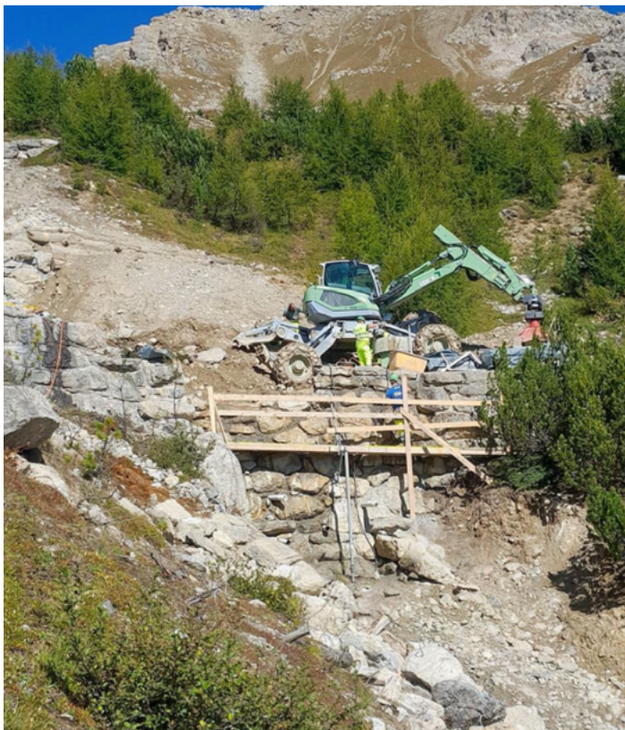
Immagine: lavori su terreni impervi
