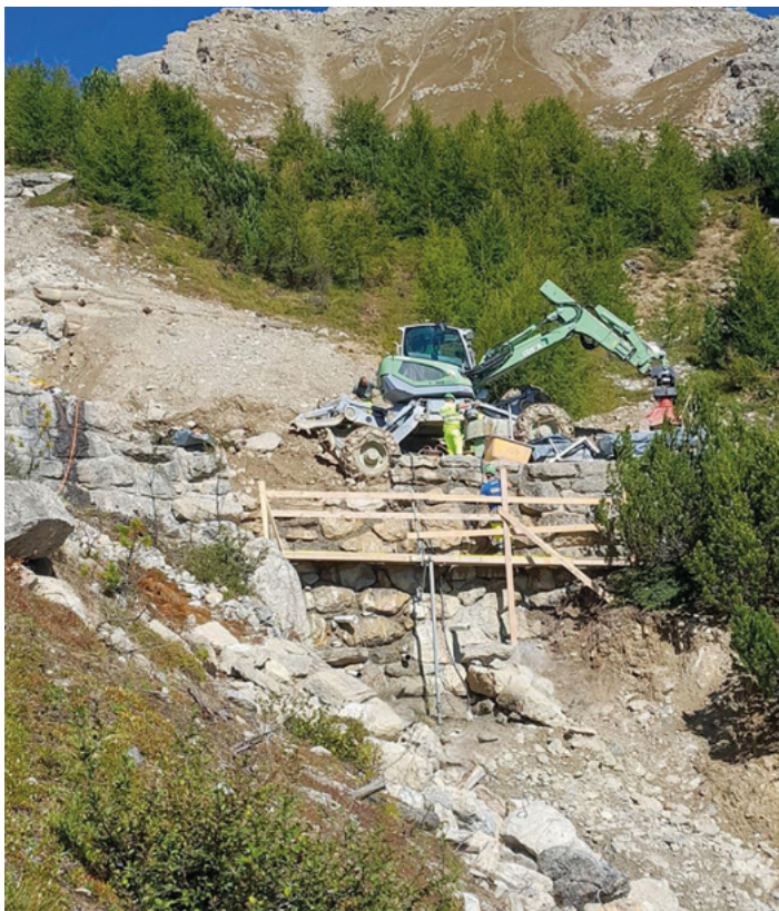
Bild: Arbeiten in steilen Geländen
